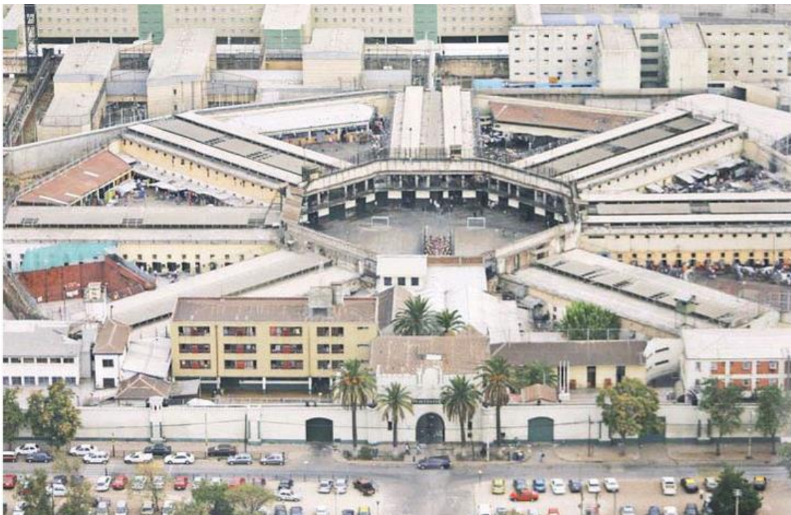
Ilustración 1: Centro de Detención Preventiva Santiago Sur (Ex-Penitenciaría). Fuente: https://www.pressreader.com/chile/la-tercera-especiales3/20180825/281616716228235
