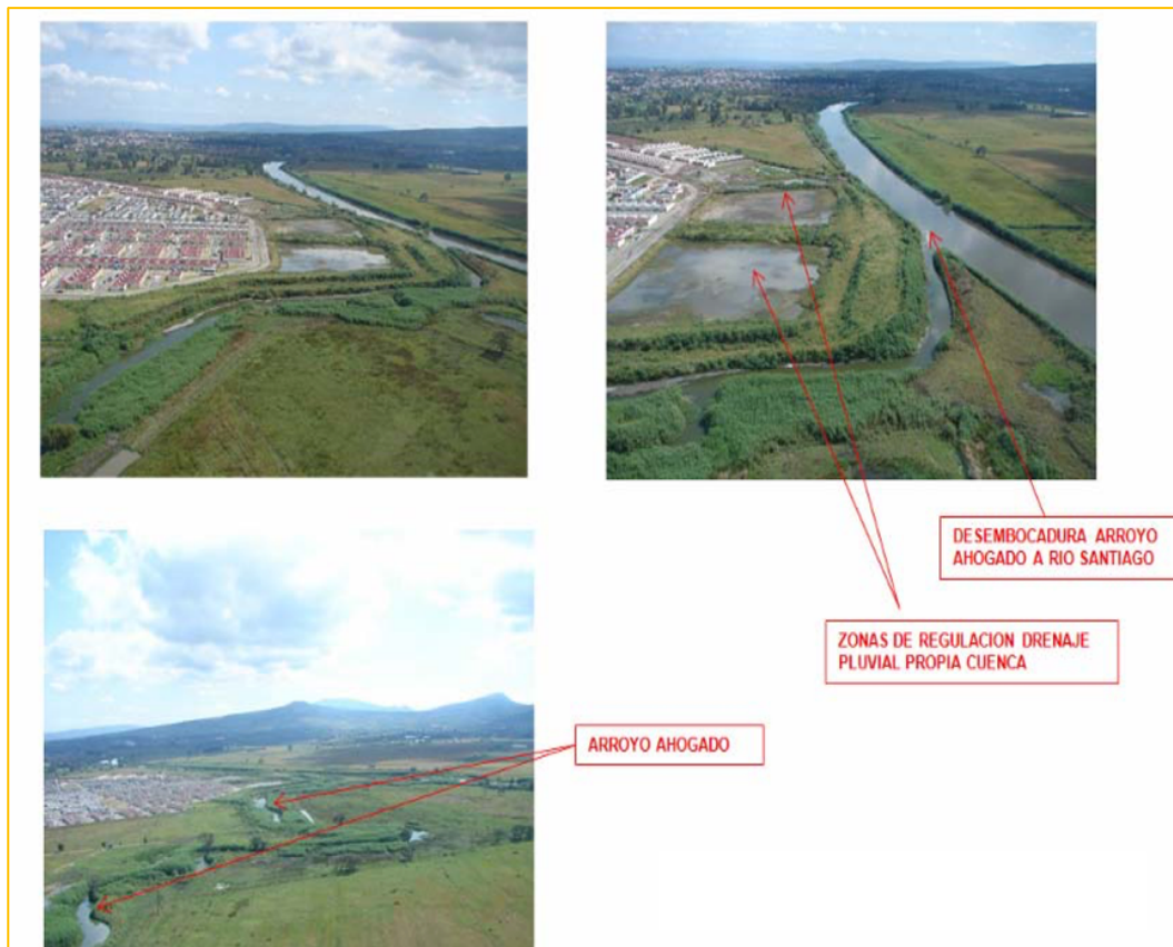
Figura 5 Vista aérea de la unión del canal del Ahogado con Río Santiago en la parte Sur del Fraccionamiento La Azucena, antes de la rectificación del cauce.
