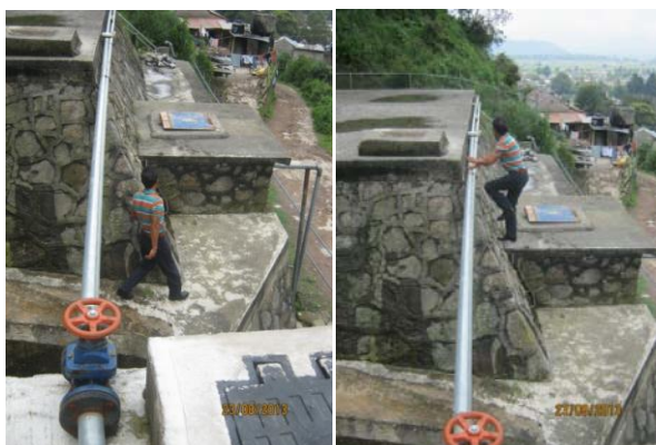
Fotografía 7. Válvula de distribución y caja de agua
