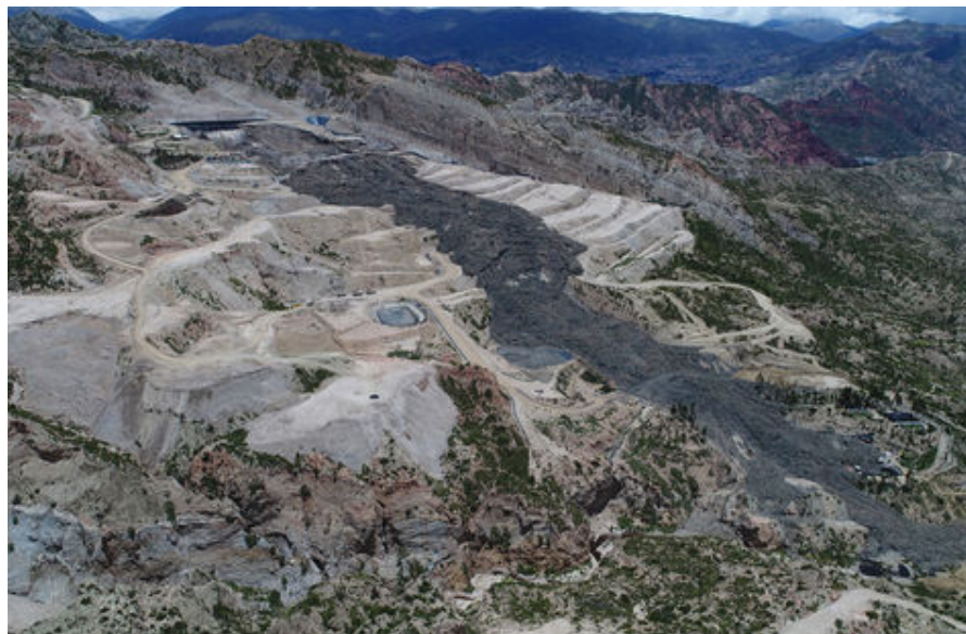
Figura 9. Deslizamiento del Relleno Sanitario Nuevo Jardín de Alpacoma
